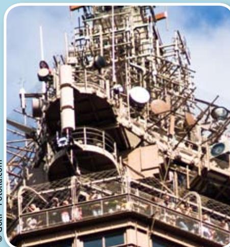
Au sommet de la tour, des dizaines d'antennes sont installées. Elles permettent de diffuser les chaînes de radio et de télévision à Paris et dans les villes voisines.
